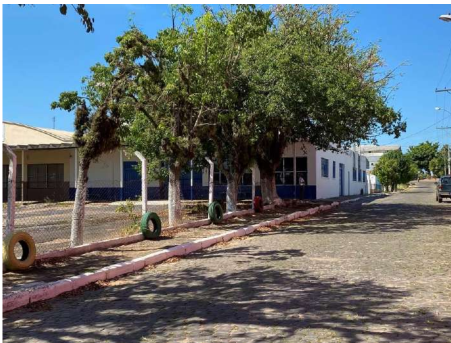
Vista da testada do imóvel para a Rua Luis Müller Picarelli
