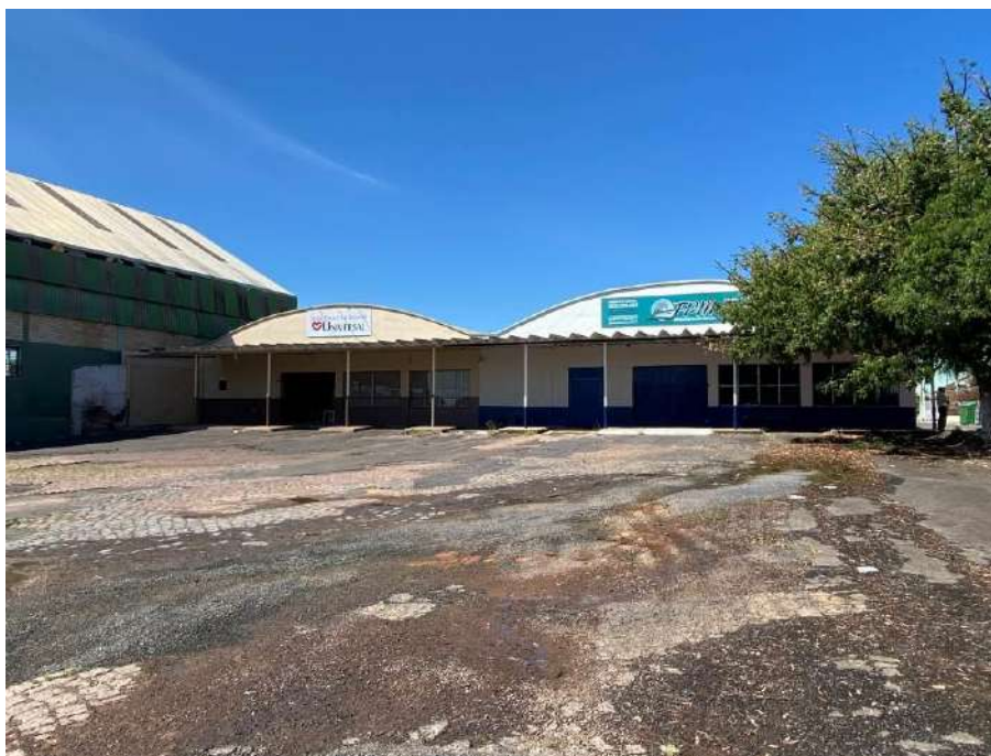
Vista geral do imóvel tomada pela Rua General Osório
